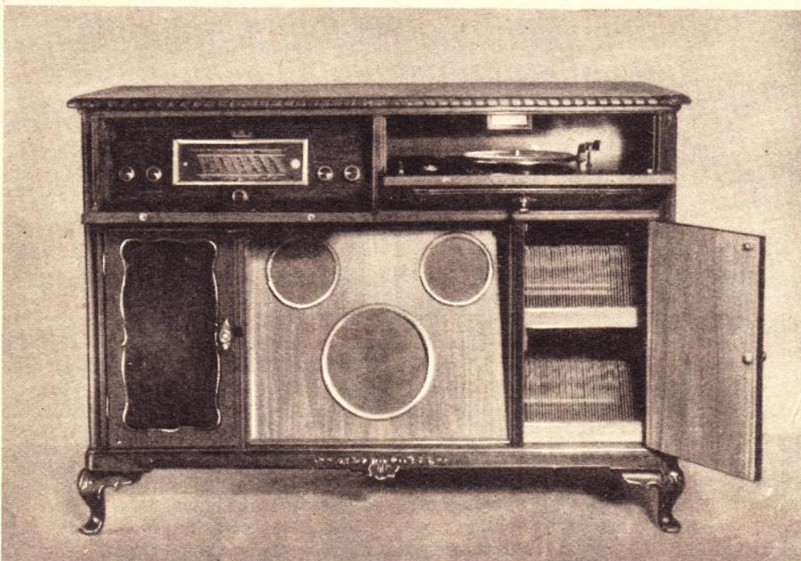
Der Groß-Musikschrank „Titan 2“ von Waldschmidt, Mehly b. Kappeln/Schlei, enthält einen Sechskreis-Super und einen Dreikanalverstärker mit 13 W Sprechleistung, drei Lautsprecher u. zw. ein Hodttonsystem, ein Mittel- und ein Tiefton-Chassis, Plattenspieler, ein Magazin für 120 Platten
